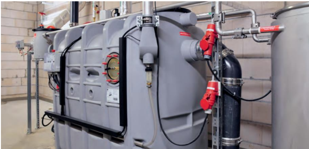
Abbildung 7.19 Fettabscheideanlage aus Kunststoff (Quelle: Internet, www.eco.at )
