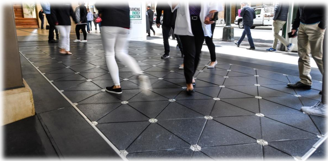
Abbildung 9.5 Einbindung der Druckplatten in Einkaufszentren / Schaubild (Quelle: Internet / google; Suchbegriff Pavegen)
